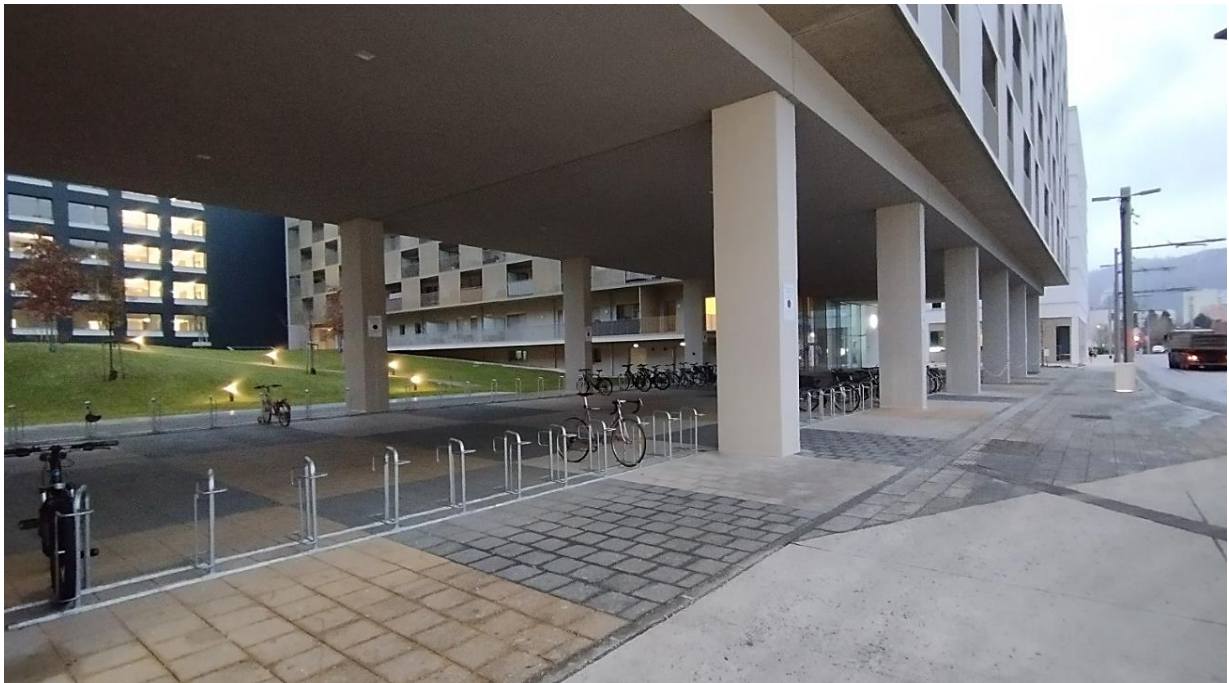
Abb. 20: FA im überdachten Außenbereich SC Mitte, (MEDIAN WB-Straße 106a – 106b)
