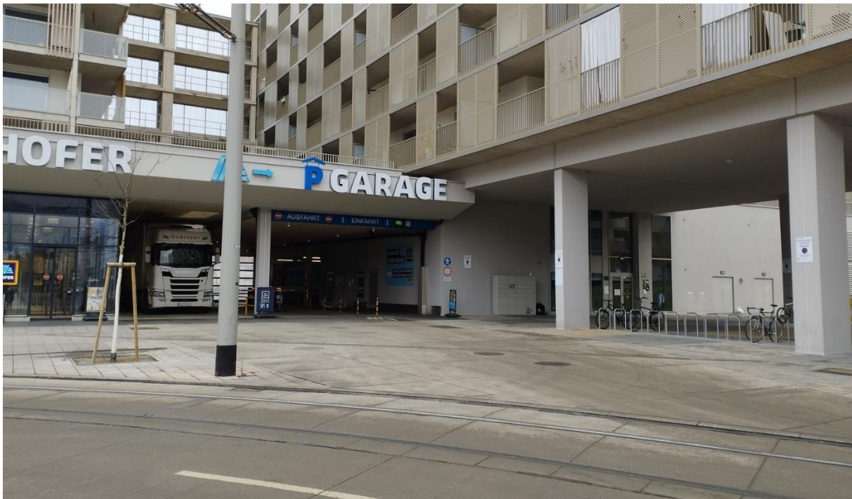
Abb. 62: SC Mitte, Zufahrt Sammelgarage und öffentliche Garage:
